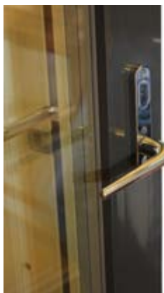
Ovilehti liikkuu vapaasti. Aukipitolaite ei lukossa.
