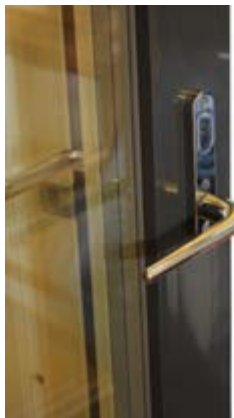
Ovilehti liikkuu vapaasti. Aukipitolaitte ei lukossa.
