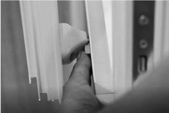
Ikkunan aukipitolaitteen lukituksen vapauttaminen
