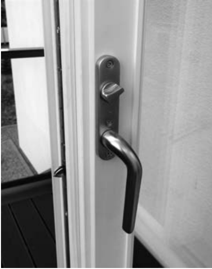
Alumiinipintaisen parvekeoven vääntönuppi ja pitkäsulkija, painike kiinniasennossa
